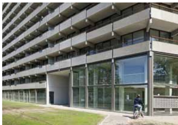
Иллюстрация 10. Project De Flat , Bijlmermeer. Амстердам, Голландия. Автор: NL Architects и XVW architectuur. 2016 г. Источник: https://www.archdaily.com/ . Фото Marcel van der Brug
